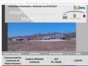
Tertiaire / Neuf - Chantier de l'hôtel d'entreprises de 1238 m 2 à Mane (04)
