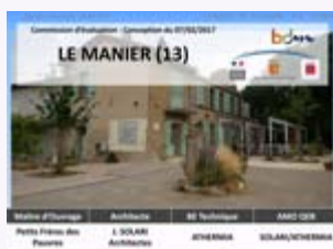
Tertiaire / Neuf & Réhabilitation - Campagne Le Manier de 532 m 2 à Marseille (13)
